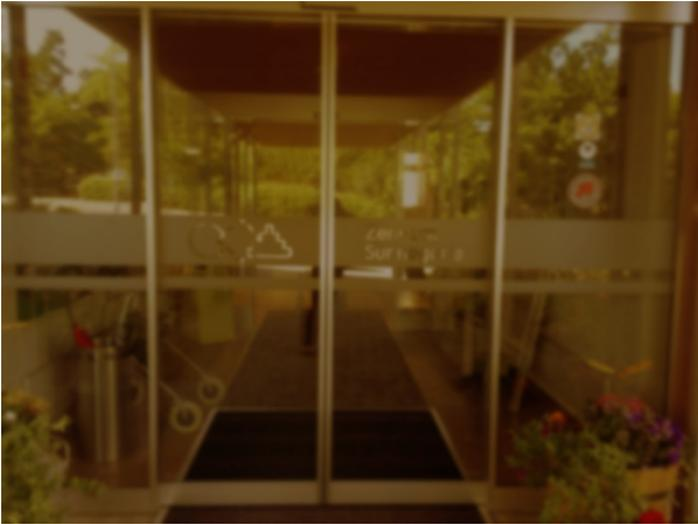
Die Gebäudebeschriftung auf dem verglasten Haupteingang («Zentrum Sunnegarte») ist unlesbar, aufgrund eines ungenügenden Kontrastes und einer Spiegelung.
